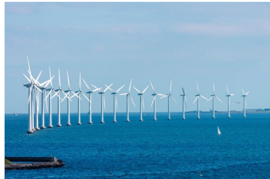
2. fénykép: Tengerre telepített szélenergia
